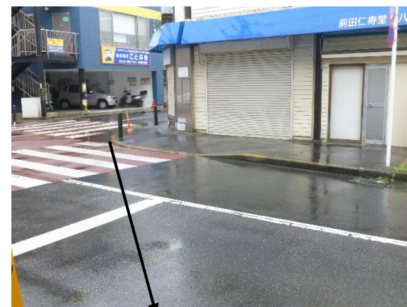
美住薬局前交差点の滞水状況
